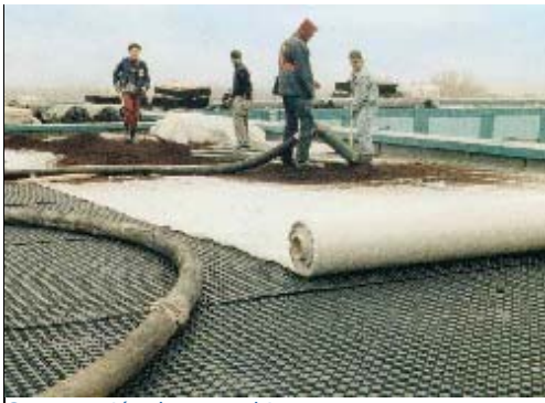
Construcción de una cubierta.
